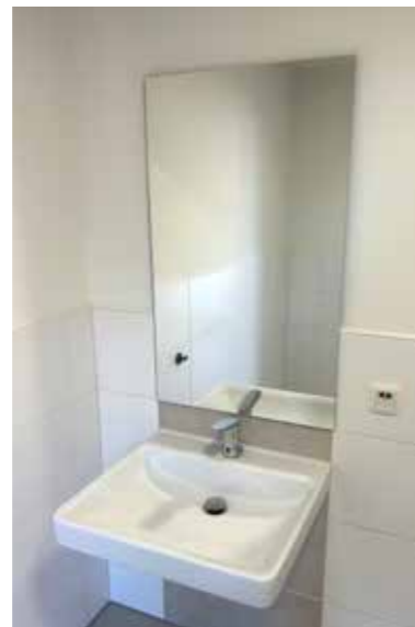
Bild 05 Flächenspiegel mit Splitterschutz (Frontansicht)
